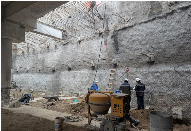
Figura 18. Anclas activas instaladas.
