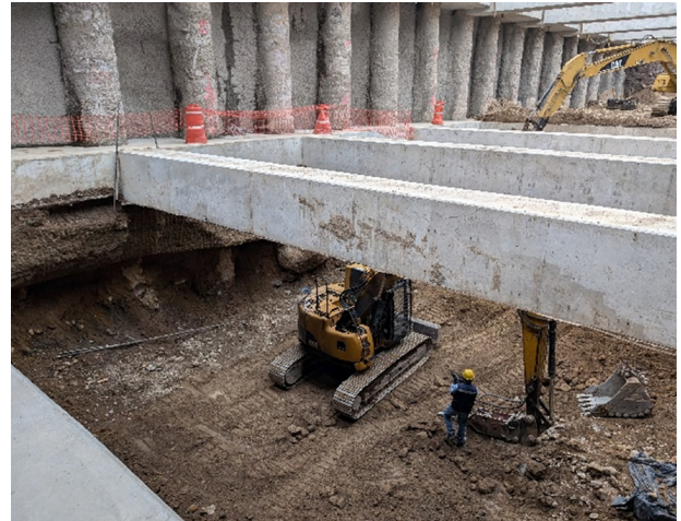
Figura 13. Excavación por debajo del segundo nivel de puntales.
