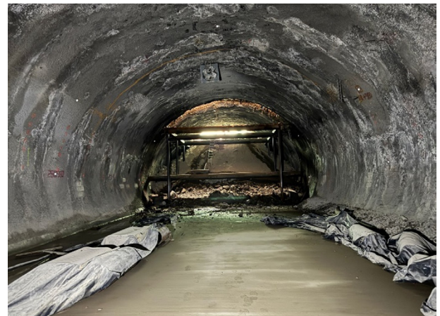
Figura 14. Puntales instalados en el interior del túnel.
