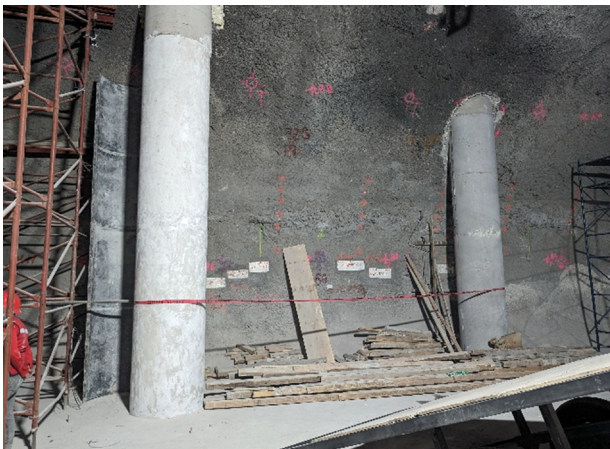
Figura 10. Pilas centrales que atraviesan el túnel.
