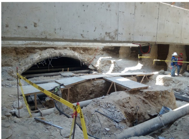
Figura 15. Tramo de túnel descubierto tras la excavación.
