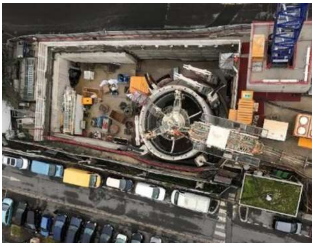
Figura 5. Vista del lugar de trabajo de hincado de lumbreras en condiciones urbanas, París (Francia).
