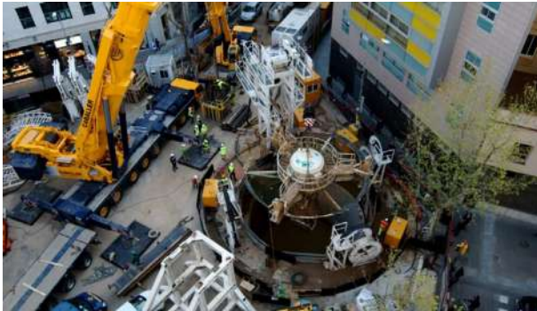
Figura 7. Construcción con equipo VSM de lumbreras de ventilación y de emergencia en Barcelona.
