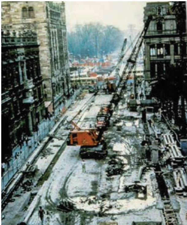
Figura 2. Muros Milán, metro línea 2.
