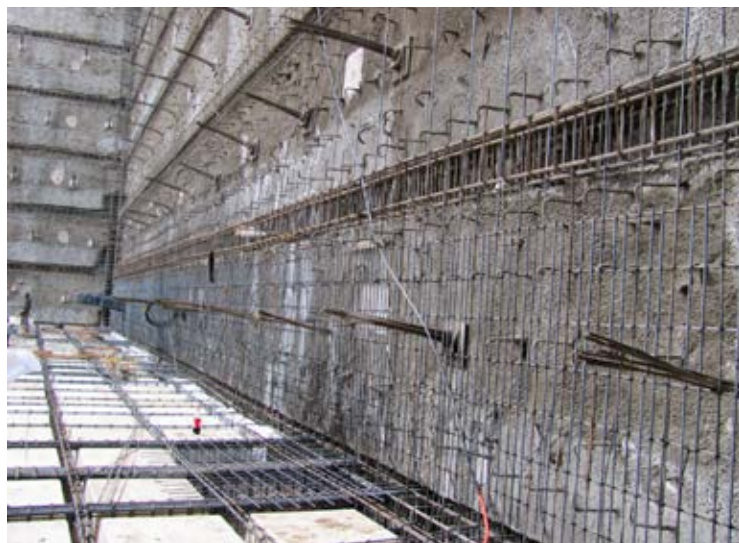
Detalle de las condiciones del anclaje, el muro de contención y el sistema de piso como elemento de troquelamiento.
