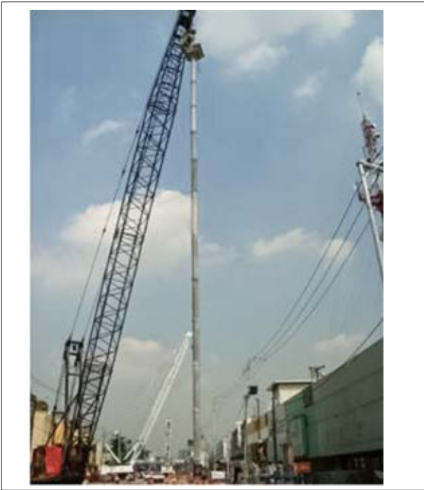
Figura 17. Tubería tremie armada.
