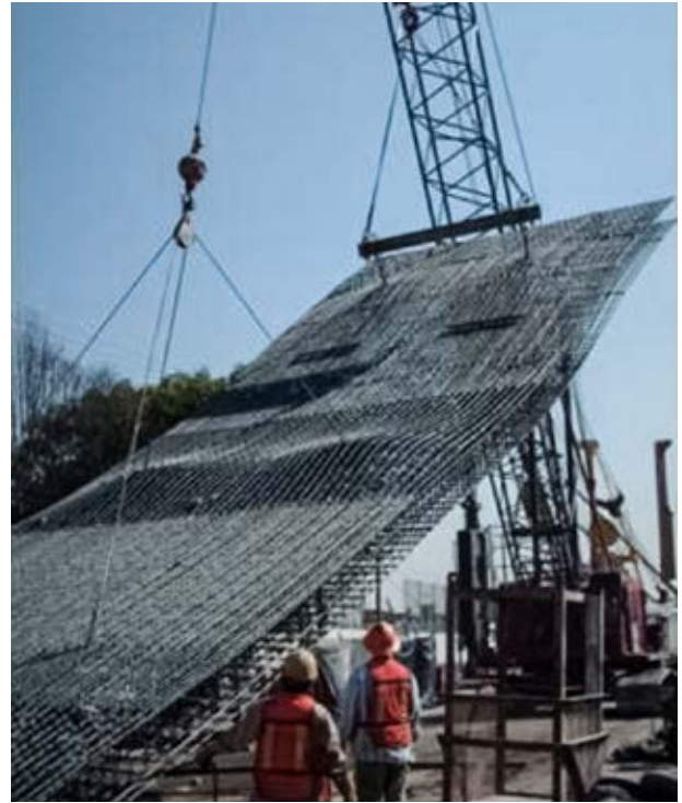
Figura 16. Izaje de un armado de muro Milán.
