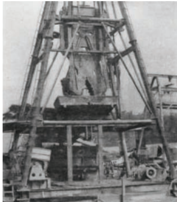
Figura 6. Primeras almejas para muros Milán.
