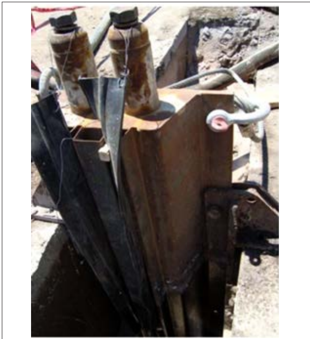
Figura 15. Junta metálica con doble banda impermeabilizante.
