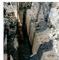
Construcción de muro Milán de 45 cm de espesor y una profundidad de 13.50 m Calle Dr. Arce #71, Col. Doctores.
