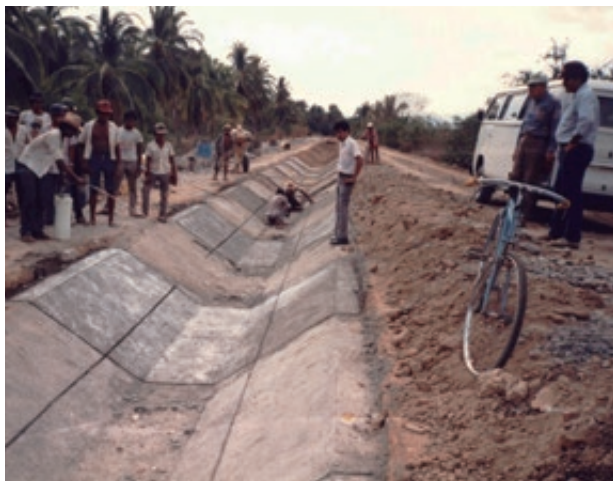
En las obras de la presa Río Verde y su zona de riego en Oaxaca, con Jorge Camacho Gaxiola, residente de los trabajos. Marzo de 1988.
