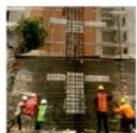
Construcción de muro Milán de 45 cm de espesor y una profundidad de 13.50 m Calle Dr. Arce #71, Col. Doctores.
