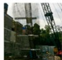
Construcción de muro Milán de 45 cm de espesor y una profundidad de 13.50 m Calle Dr. Arce #71, Col. Doctores.
