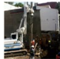
Construcción de pilas de 80, 100, 120 y 140 cm de diámetro a una profundidad de 30 m en la calle Amores 827, Col. Del Valle.
