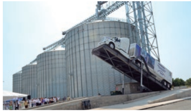
Figura 7. Terminal de granel agrícola en Puerto Chiapas.
