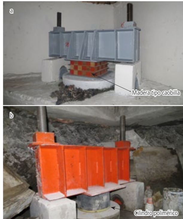
Figura 5. Pilotes de control in situ : a) celdas de deformación de madera; b) cilindros poliméricos (II-UNAM, 2016).
