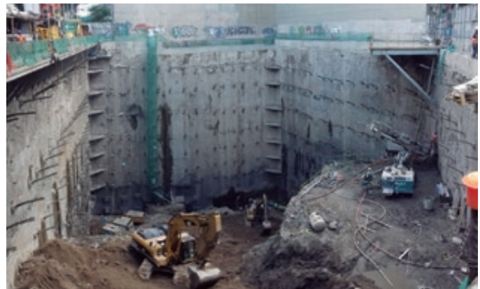
Excavación y anclaje de muro, del. Benito Juárez
