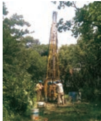
Realización de pruebas geotécnicas, Cd. de México
