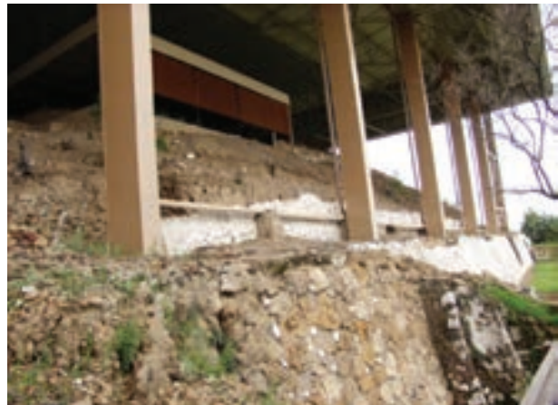
Figura 2. Vista parcial de la gran cubierta metálica y de uno de los lados inclinados del sitio.
