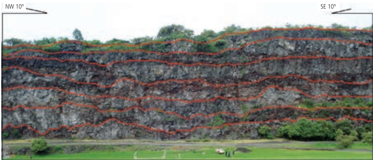
Figura 6. Vista de la sección NW 10° SE de las diferentes coladas de basalto que se observan desde el mirador de la cantera (foto del autor).
