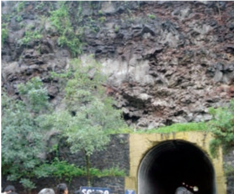
Figura 5. Salida del túnel hacia la calle Totonacas dentro del Club Pumas. Se puede apreciar la roca masiva basáltica y el material escoriáceo (foto del autor).
