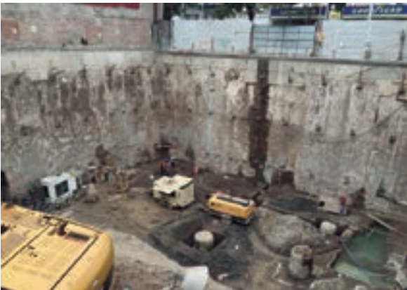
Diseño y construcción de muro Milán anclado. Av. Patriotismo, Cd. de México
